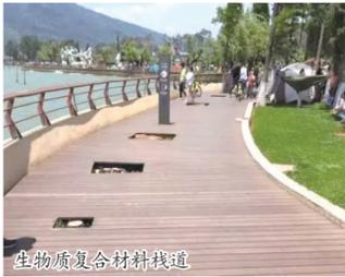
生物基无机复合材料栈道
