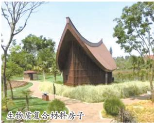
生物基无机复合材料房子
