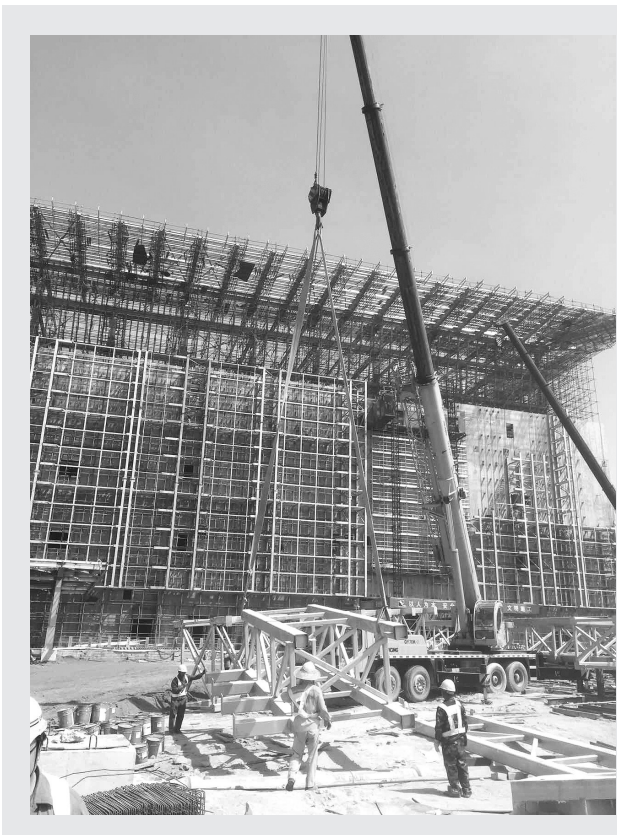
国庆前夕，港珠澳大桥工程建设取得新进展。经过上海建工安装集团上千建设者的努力，目前已顺利完成港珠澳大桥旅检大楼17万平方米的空调安装任务，同时400多台冷冻机组、新风机组等大型设备安装就绪。尤其是在工地遭受“天鸽”、“帕卡”两场特大台风袭击下，广大建设者与时间展开了一场竞赛，顺利抢先敷设了5公里大型电缆，为整个工程实现年内具备通车条件奠定了基础。 通讯员 孟好特 殷庆 摄影报道
